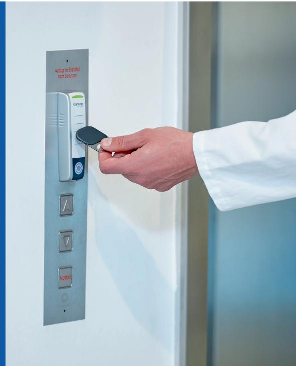
Die im Design schlank und schlicht gehaltenen Zutrittskontrollleser der Serie GAT SLR 73xx bestehen durch Multifunktionalität, einfachste Montage und die neue „Plug&Play PLUS“ Funktion. Die Leser dienen der Identifikation von Personen und verwenden dazu berührungslose RFID Ausweise. Sie werden über die strukturierte Gebäudeverkabelung am Zutrittscontroller angeschlossen.
